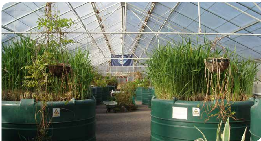
Reovee puhastussüsteem Findhornis, mille väiksem mudel ongi EcoKit SVEN ALUSTE
